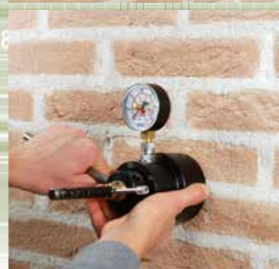
Rapida installazione con Mandrino Steel DryFix® 10 e verifica delle prestazioni in cantiere
